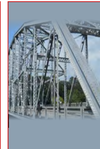
Köprü ve Diğer Yapılar Bridges and Other Structures
